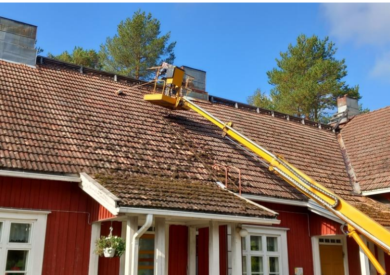
Sammaleet poistettiin katolta mekaanisesti käyttäen harjan kumpaakin päätä.
