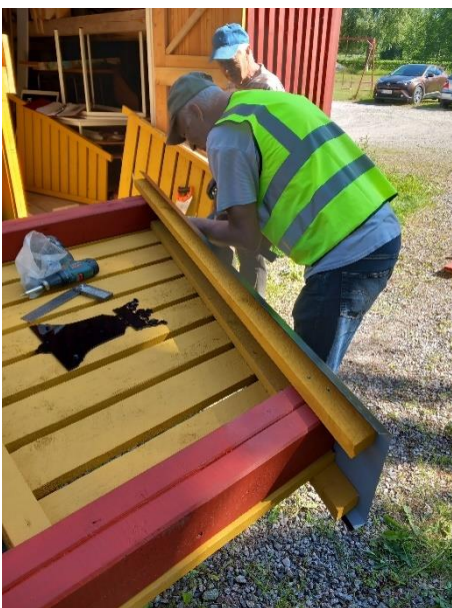
Kuvassa tehdään loppukokoonpanoa ennen porttien siirtämistä pystytyspaikoille.
